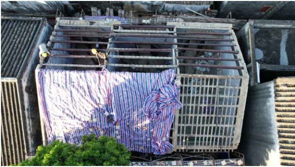
维修中的杨鹤龄展厅
