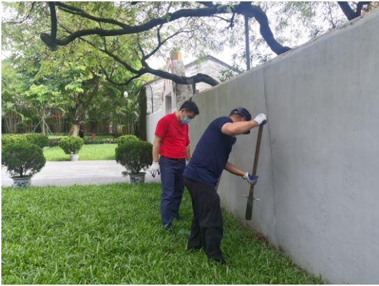
白蚁预警监测系统安装施工
