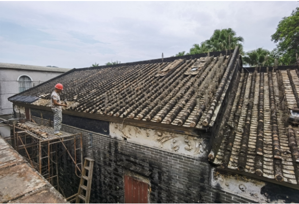
维修泰和街13号民居滑落的瓦筒
