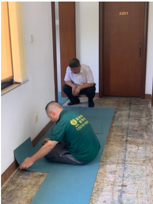
翠亨楼地毯更换工程 (施工中)
