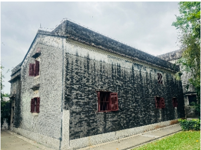
杨殷故居防雷工程 (施工后照片)
