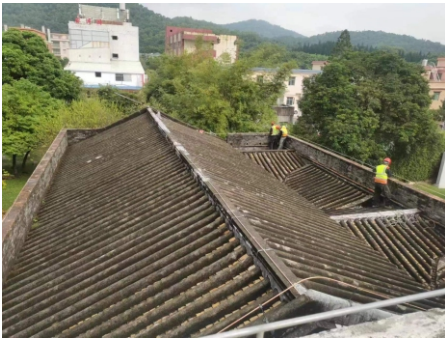
杨殷故居防雷工程 (施工中照片)
