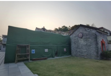
非遗二期歌馆施工照 (施工中)
