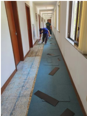
翠亨楼地毯更换工程 (施工中)
