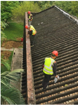
杨殷故居防雷工程 (施工中照片)
