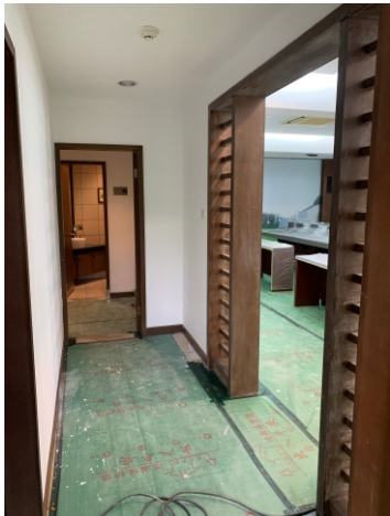
中桂厅会议室装修工程
