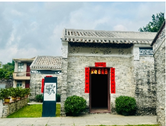
非遗二期歌馆施工后照片
