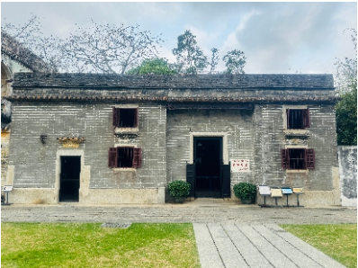
杨殷故居防雷工程 (施工后照片)
