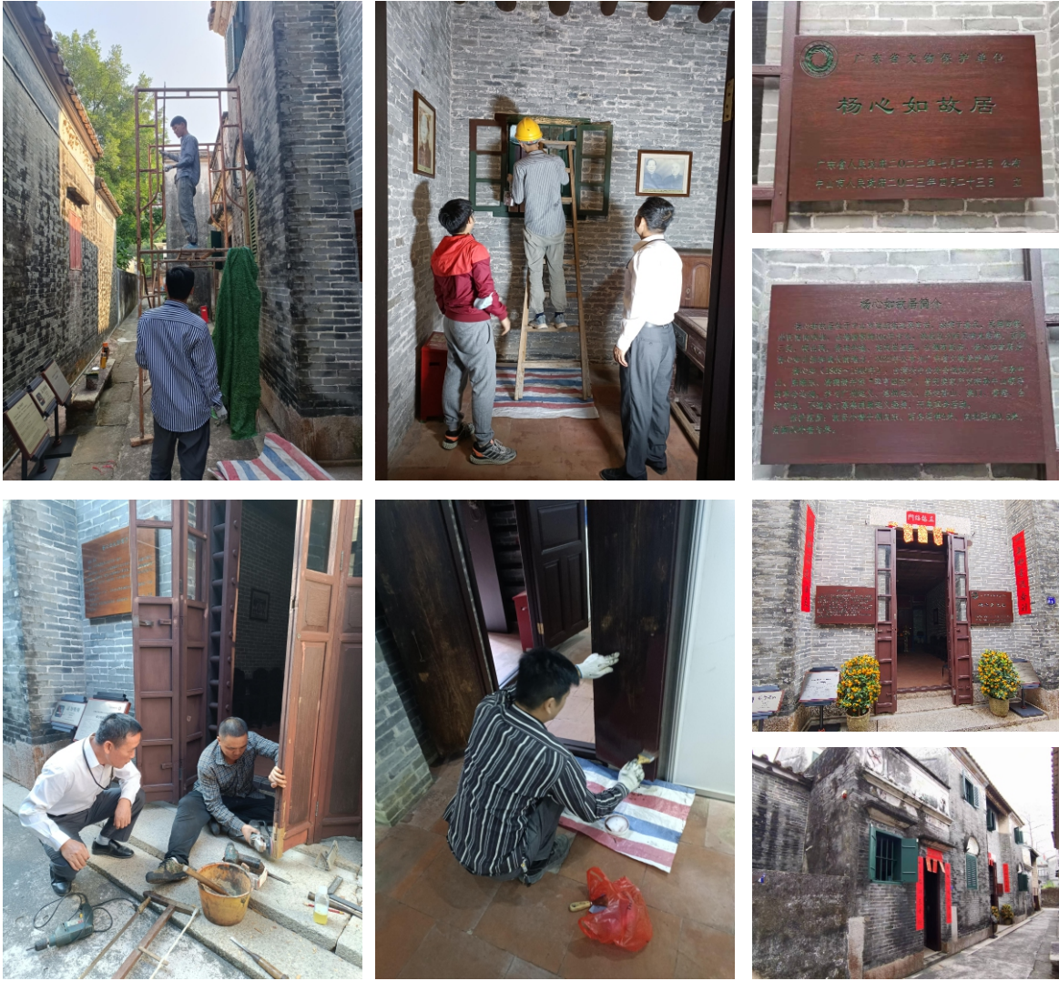
为杨心如故居制作“省保”标志说明牌及开展保养维护工程
