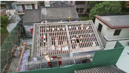
非遗二期歌馆施工照 (施工中)
