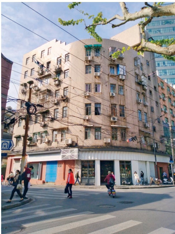
武进路247号中华海员总工会总会大楼旧址现状
